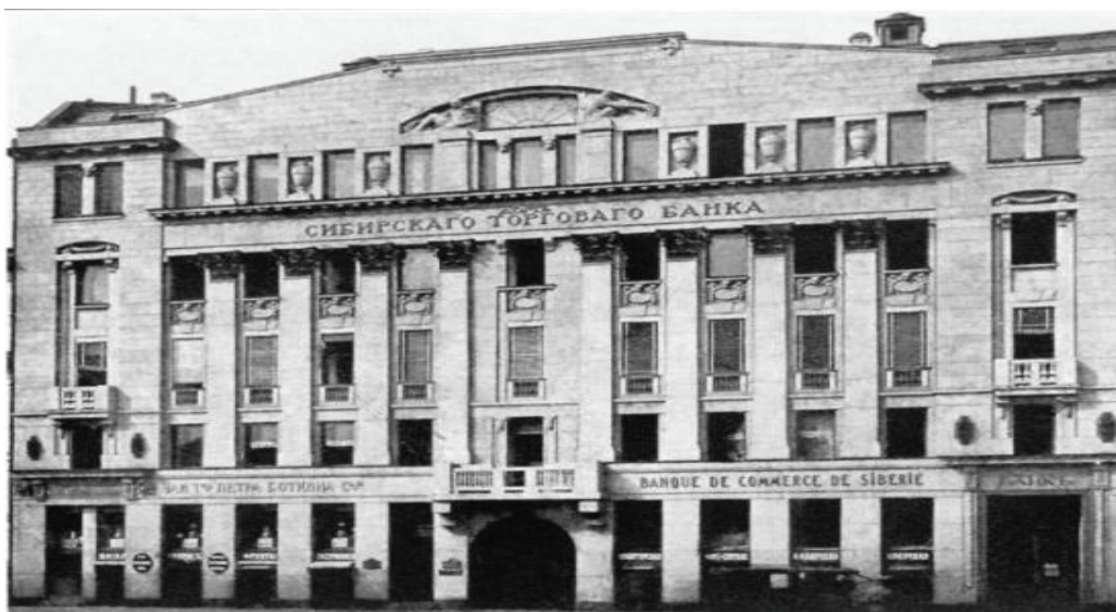
Рис. 2. Дом 44 на Невском пр. (фото начала XX в.)
